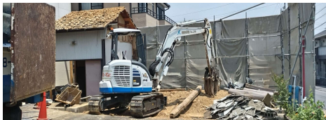
取壊し中の様子
