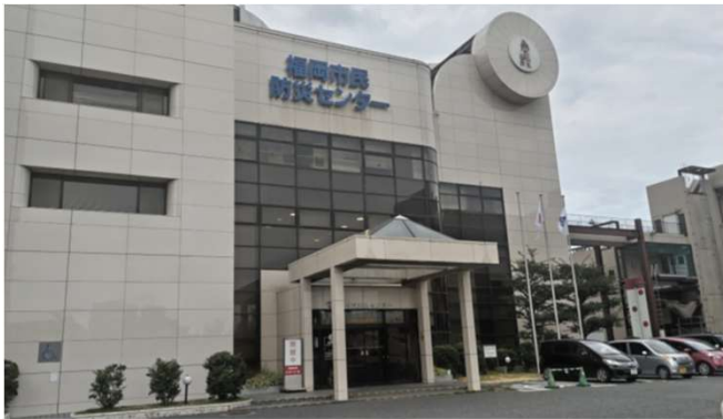
防災センター外観
